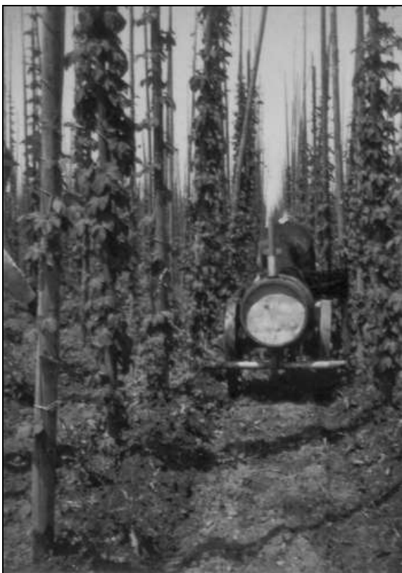
Slika 17: Nova Roblekova lesena cisterna za gnojnico, zalivanje z vodo in škropljenje hmelja okrog leta 1930 (vir: fotoarhiv OEIKA FF UL).
