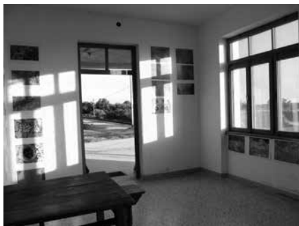
Ulaz u čekaonicu željezničke postaje Savićenata
