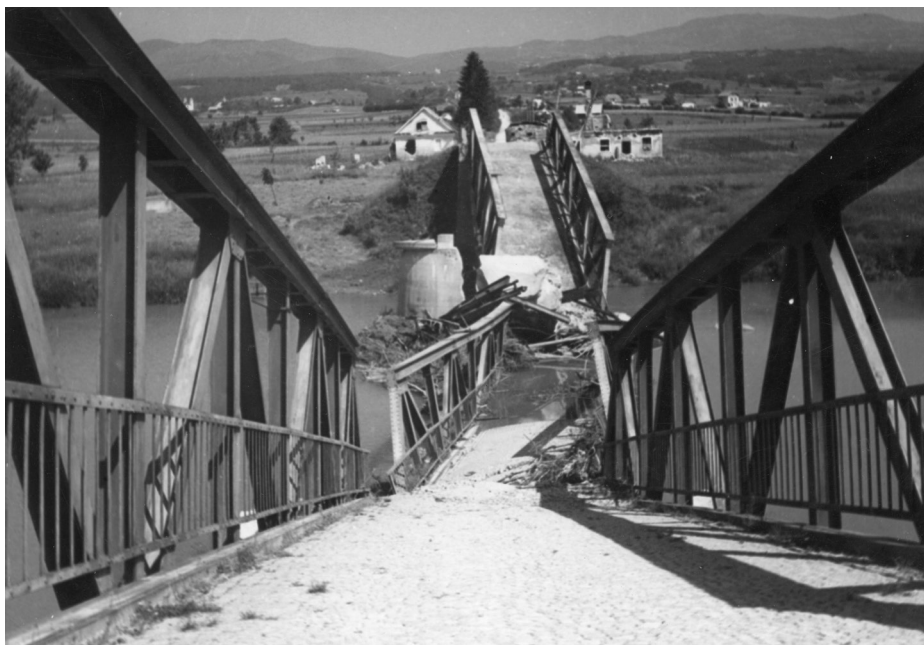
Slika 24: Partizani so septembra 1943 po kapitulaciji Italije porušili cestni most prek Kolpe pri Metliki. Na desni strani mostu je vidna tudi napol podrta hiša, ki so jo Italijani spremenili v bunker (glej sliko št. 10).
