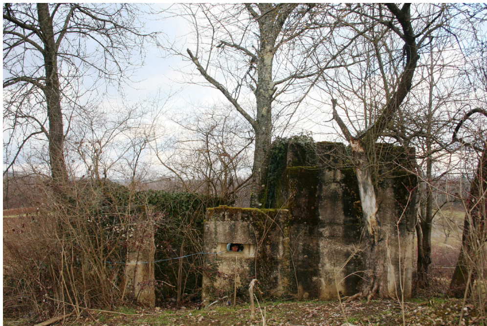
Slika 20: Italijanski bunker pri vasi Rosalnice.
