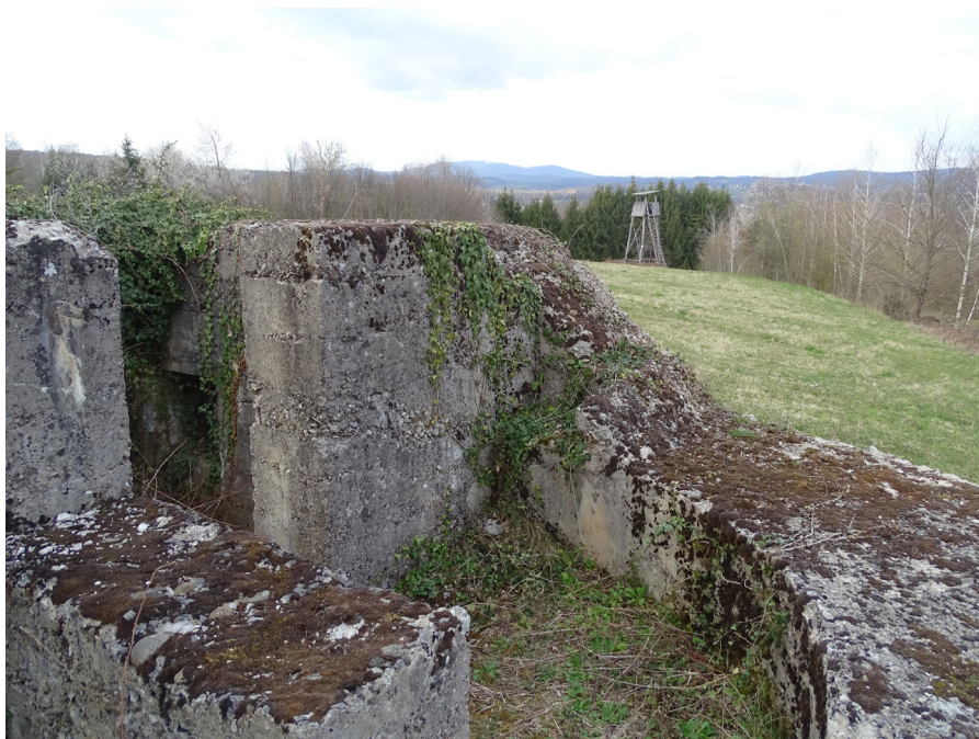
Sliki 21 in 22: Italijanski bunker na koti 206 severno od vasi Rosalnice.
