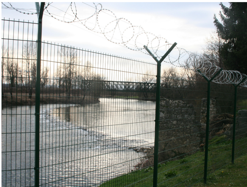
Slika 9: Panelna ograja in na njej rezilna žica na bregu Kolpe pri vasi Radoviči. V ozadju je železniški most čez Kolpo. 9. marec 2019.
