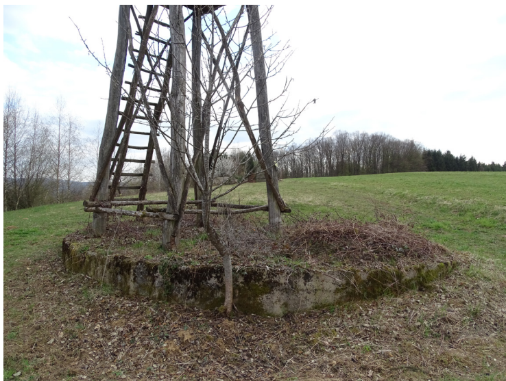
Slika 23: Lovska preža na koti 206 severno od vasi Rosalnice stoji na betonski plošči, ki bi lahko bila ostanek nedokončanega italijanskega bunkerja.
