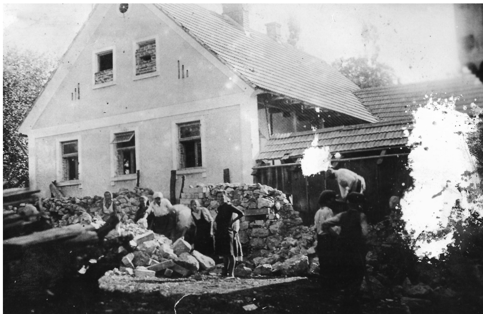
Slika 10: Rušenje bunkerja pred hišo v Ziljah ob cesti Vinica – Preloka. Bunker so rušili takoj po italijanski kapitulaciji. (Fotografija last Janez Uršič).
