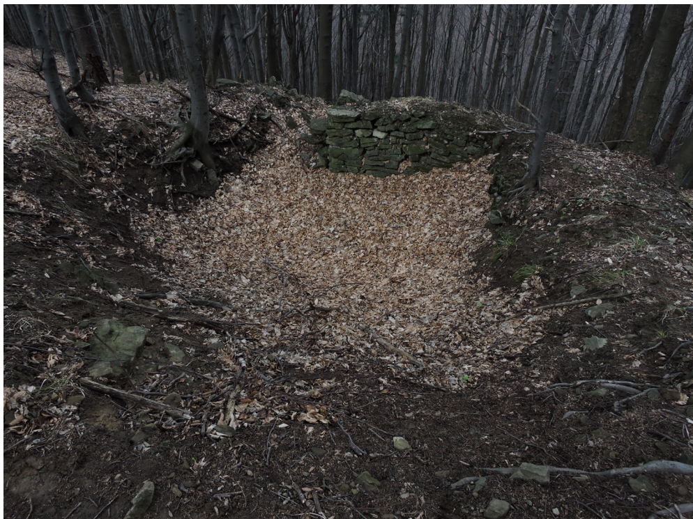
Slika 10: Ostanek nemškega bunkerja na Maclju. Bunkerji na Maclju so imeli dimenzije od približno 5 krat 5 m do približno 7 krat 7 m.
