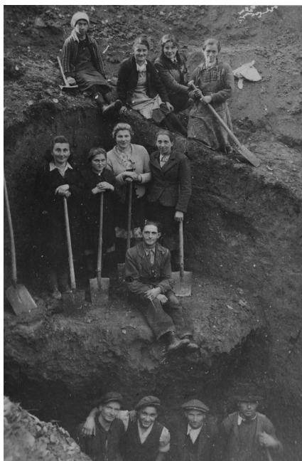
Slika 5: Nemško obrambno linijo so pretežno gradili prisilno mobilizirani krajevni prebivalci. Na sliki kopanje bunkerja pri Vonarjah pri Rogaški Slatini.
