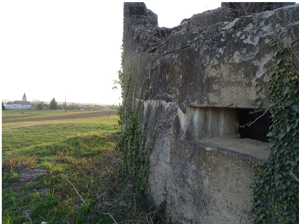
Slika 7: Bunker pri vasi Rosalnice, 28. marec 2019.
