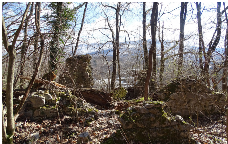
Slika 31: Ostanki bunkerja, zidanega iz kamna in opeke na pobočju Jurjevca.
