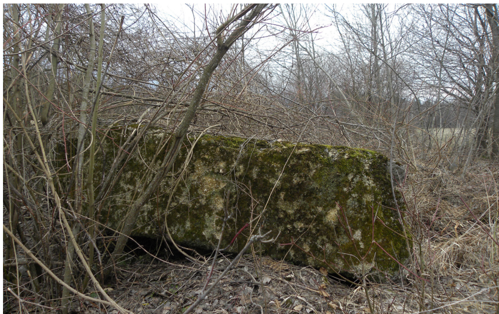
Slika 39: Betonski blok, zidan iz kamna in opeke, ki je ostanek bunkerja na vrhu Jurjevca, 28. 3. 2018
