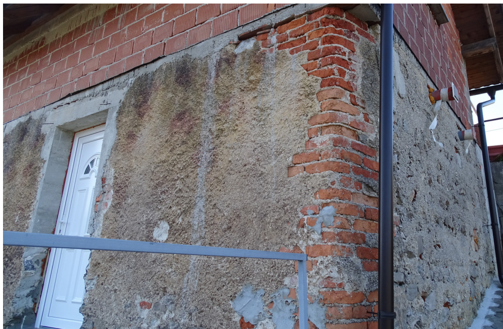
Slika 28: Na ruševinah nekdanjega bunkerja na južnem pobočju Tolstega vrha je bila v 21. stoletju zgrajena zidanica. Na fotografiji je še viden zid nekdanjega bunkerja.
