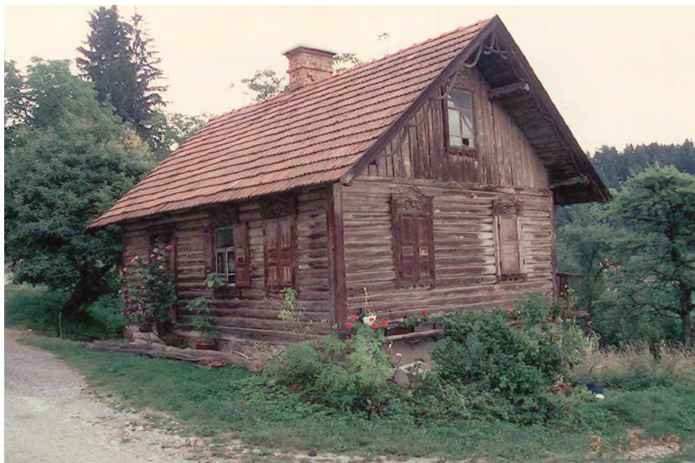
Fotografija 22: Lesena ruska hiša, ki jo je okrog leta 1922 zgradil Zavodnjčan, sicer avstro-ogrski vojak, ko se je srečno vrnil iz ruskega ujetništva domov na Zavodnje. Hišo je nekdanji vojak zgradil po načelih skeletne konstrukcije, tj. s pokončnimi žlebljenimi lesenimi stebri, v katere so drug vrh drugega vodoravno vtaknjeni plohi. Vito Hazler, Zavodnje, 1985.
