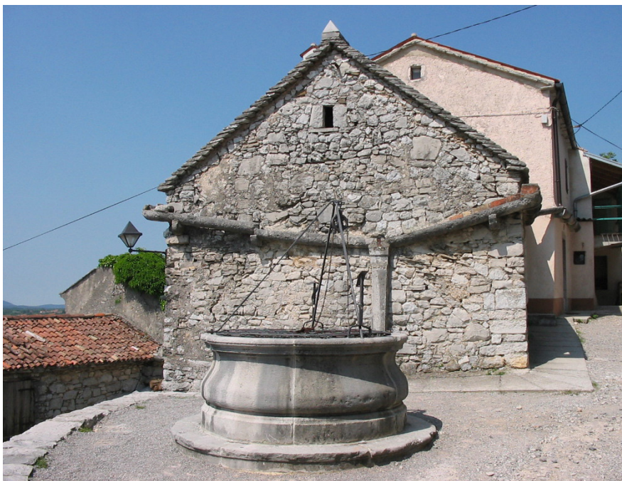
Fotografija 8: Kraška hiša je v celoti zgrajena iz kamna, od temeljev in sten do kritine in odtočnih žlebov. Vito Hazler, Štanjel, 2004.
