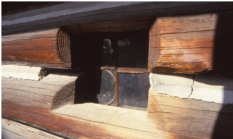
Fotografiji 19 in 20: Dvoje oken, vgrajenih med dve bruni lesene kladne stene v nadstropju hiše, ki ima le po eno okensko krilo, z notranje strani vgrajeno po izvornem načinu na smuk. Levo okno ima deloma še ohranjeno prvotno zasteklitev z litim steklom in zasteklitev po t. i. katedralni zasteklitvi, po kateri je lito steklo vgrajeno v mreži svinčenih žlebičev, v tem primeru pa svinec nadomeščajo leseni in v krog ukrivljeni žlebovi. Vito Hazler, Zavodnje, 1993.
