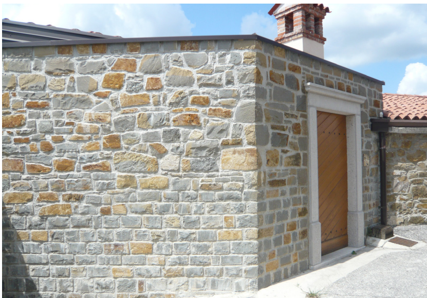
Fotografija 14: Šmartno v Brdih, novejši del vasi izven starega obzidja. V istem vidnem zidu sta več kot očitna dva načina gradnje, vendar nobeden izmed njiju ne ponazarja tisočletnega izročila gradnje s kamnom – manjkajo masivni in izmenično »šivani« vogalni kamni, ki zagotavljajo dejansko in optično (navidezno) trdnost. Vito Hazler, Šmartno v Brdih, 2014.
