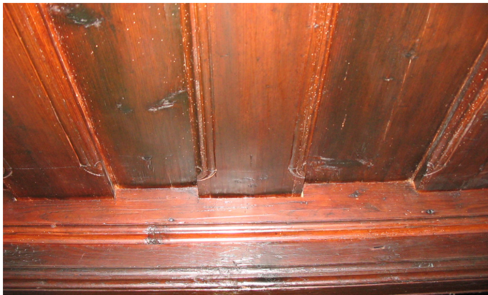
Fotografija 40: V zidani hiši naproti Barbove graščine imajo ohranjen lesen strop z bogato profiliranimi robovi in usločenimi ajdovimi zrnji, kar je pogostejša likovna rešitev na premožnejših posestih. Vito Hazler, Vesela Gora pri Šentrupertu na Dolenjskem, 1999.
