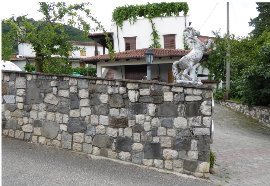
Fotografija 11: Turistična kmetija Arkade Cigoj, nov kamniti zid z obsežnim dodatkom cementne malte. Vito Hazler, Črniče, 2018.
