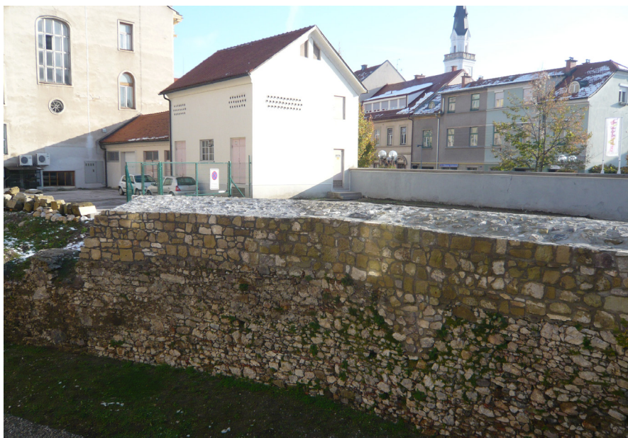
Fotografija 13: Celje, spodnji grad, prikaz in situ ohranjenega kamnitega zidu z novodobno nadgradnjo. Vito Hazler, Celje, 2012.
