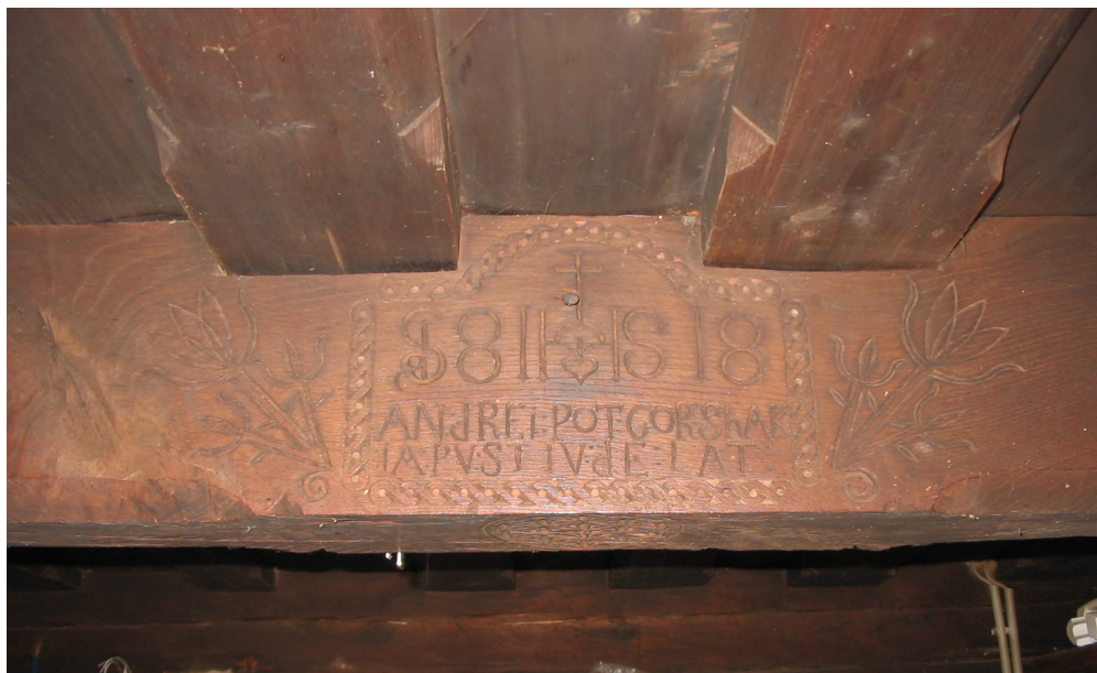
Fotografija 41: Špančeva deloma lesena zidanica s stropom z letnico 1818 in napisih o lastnikih in graditeljih. Vito Hazler, Mali Vrh, 2006.
