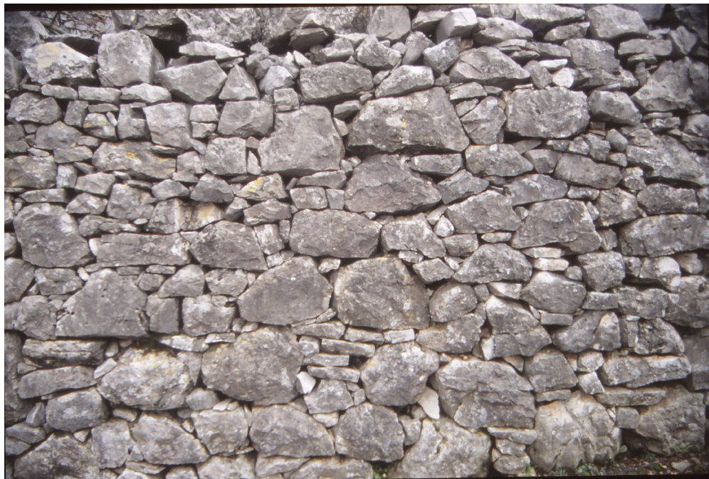
Fotografija 7: Kamniti zid brez veziv, t. i. suhogradnja. Vito Hazler, Pliskovica, 1996.
