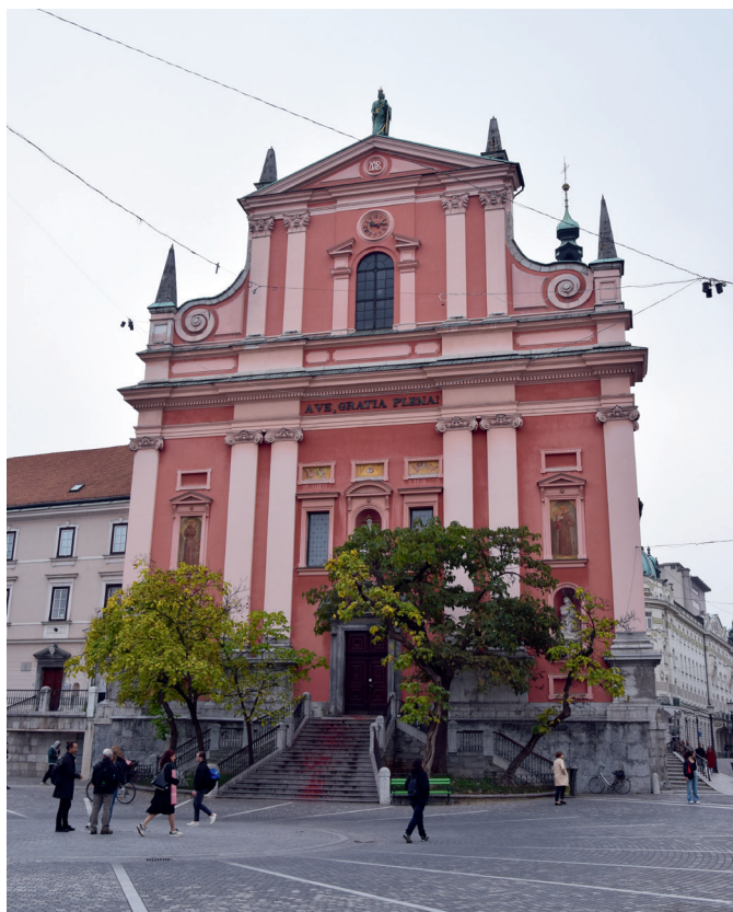
Slika 1: Pogled na glavno pročelje Frančiškanske cerkve
