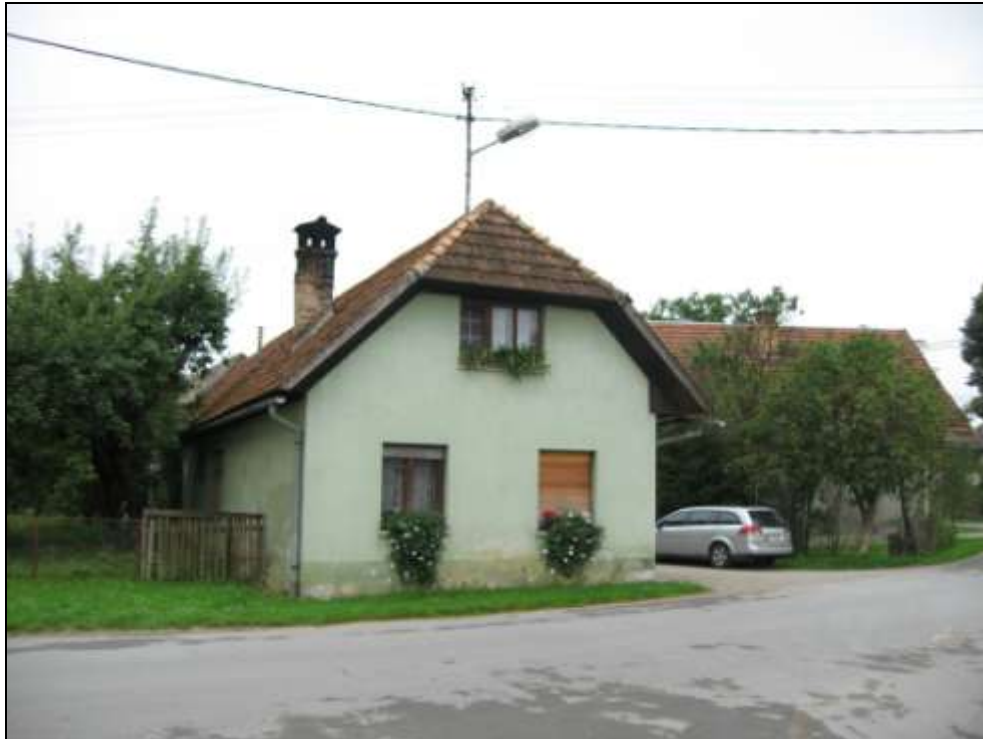
Slika 3: Hrovača 34 (prej 5). Zelo prenovljena Jecljeva hiša je sicer ohranila prvotno stavbno maso, a je izgubila vso členitev in prvotni ritem treh oken v pritličju. V prvotni podobi se je ohranil dimnik (glej spodaj) (foto: V. Hazler, 30. 8. 2007).
