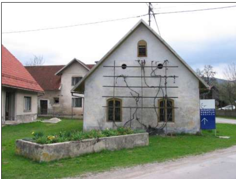
Slika 24: Podoba Kersničeve ključavničarske delavnice pred obnovo (foto: V. Hazler, 18. 4. 2006).
