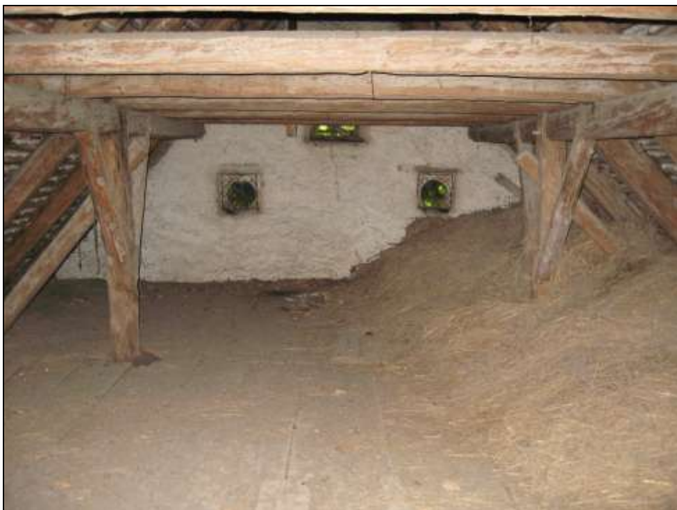
Slika 21: Podstrešje delavnice z ostrešjem v konstrukciji trapezastega povezja in ostanki sena spred več desetletij (foto: V. Hazler, 30. 8. 2007).
