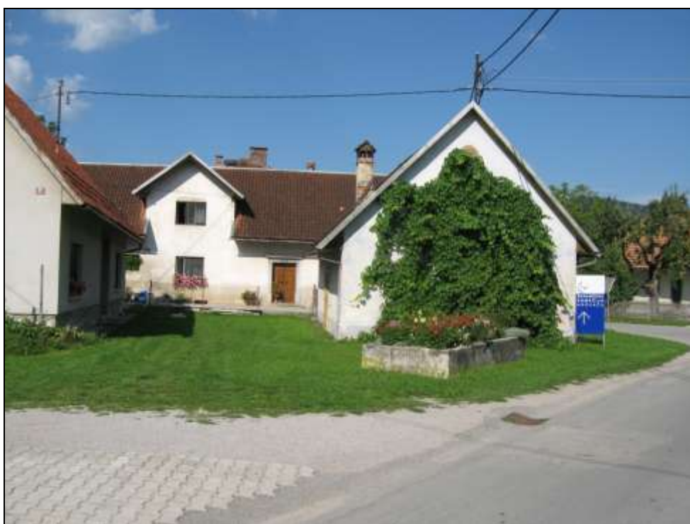
Slika 25: Podoba Kersničeve ključavničarske delavnice pred obnovo (foto: V. Hazler, 27. 8. 2007).
